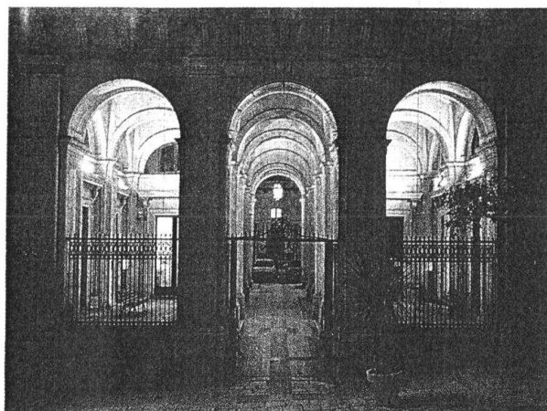
Palazzo dell'Aquila si prepara ad accogliere il nuovo sindaco dopo un anno di vacato con la guida di un commissario. Nelle foto in basso, a sinistra la sede municipale di Comiso e, a destra, il Comune di Acate
